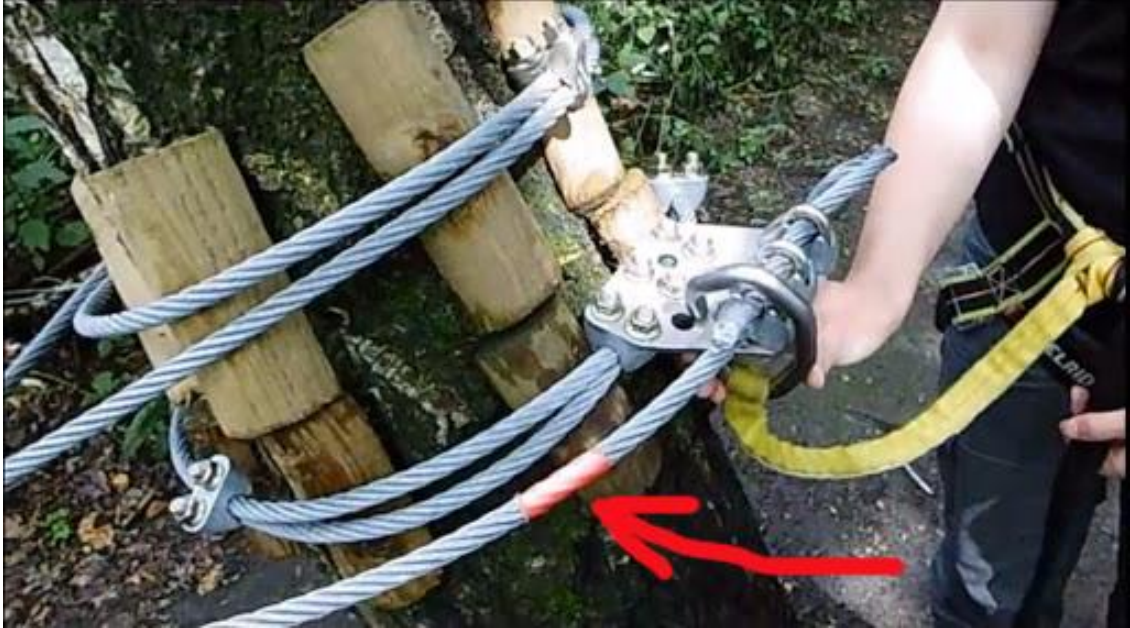
ຮູບຕົວຢ່າງຈີ່ງສິ້ນຂອງສາຍສະລິງໄວ້ປະມານ 2 – 3 ແມັດ ແລ້ວກັ້ງວສາຍໄວ້
